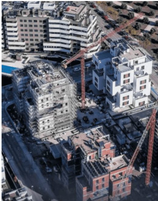
Construcción de viviendas en el sur de Madrid. ÁLVARO GARCÍA
